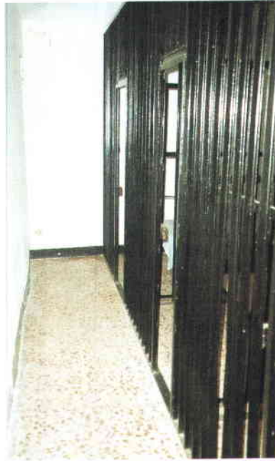
Celdas del depósito de Olivenza.
