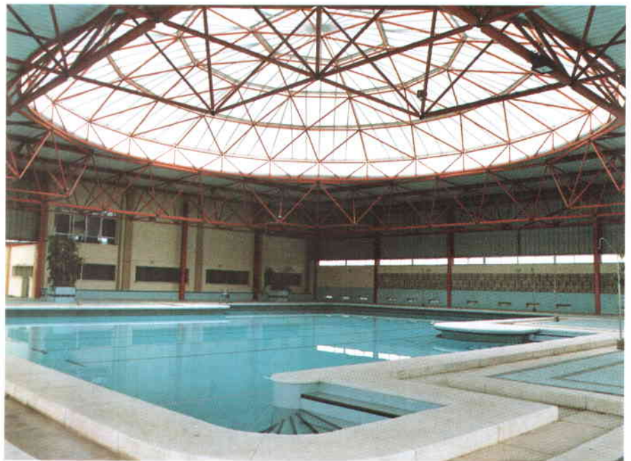
Piscina cubierta de San Juan de Alfarache.
